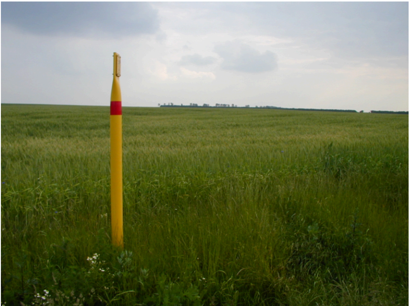
Der Schilderpfahl markiert den Verlauf einer Gaspipeline von GASCADE in Ostdeutschland. Künftig will GASCADE auch Wasserstoff-Pipelines betreiben. Quelle: Gascade
