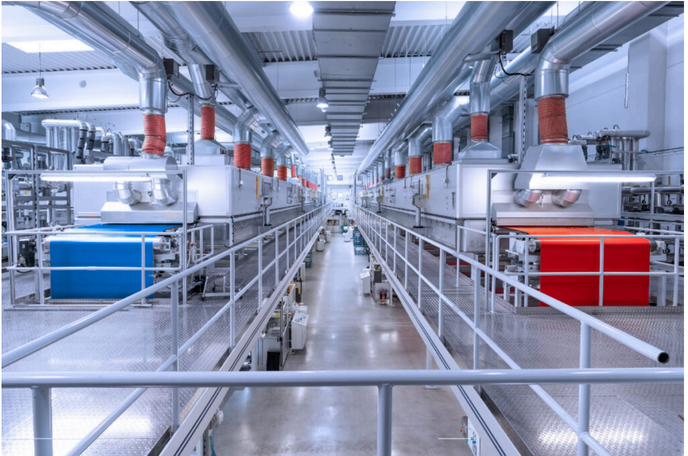
Produktionsanlage zur Herstellung selbstklebender Spezialfolien bei ORAFOL / Copyright: ORAFOL Europe GmbH
