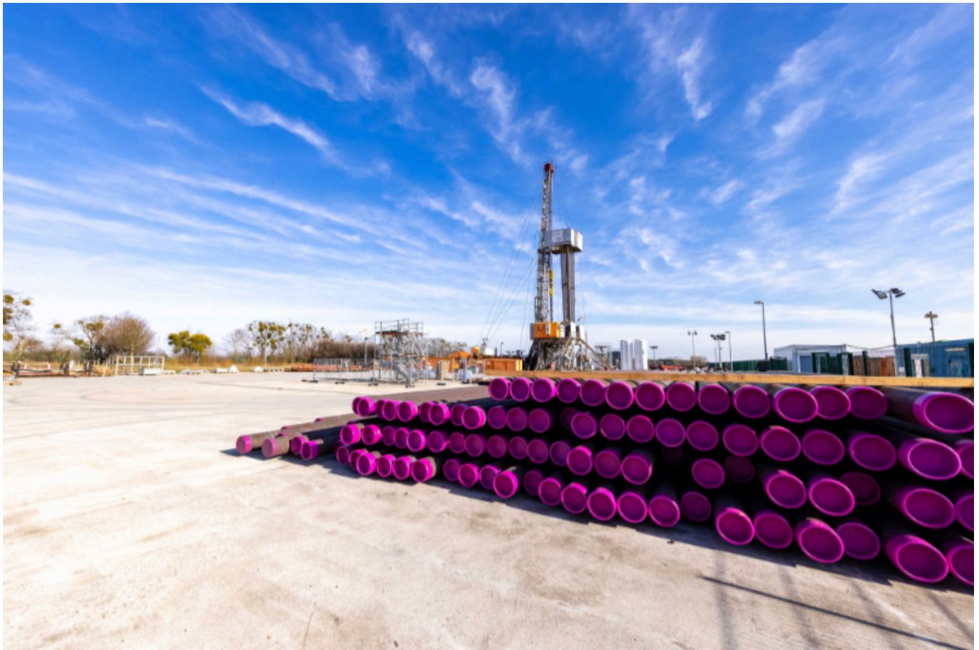
Rüdersdorf, EWE Gasspeicher.
