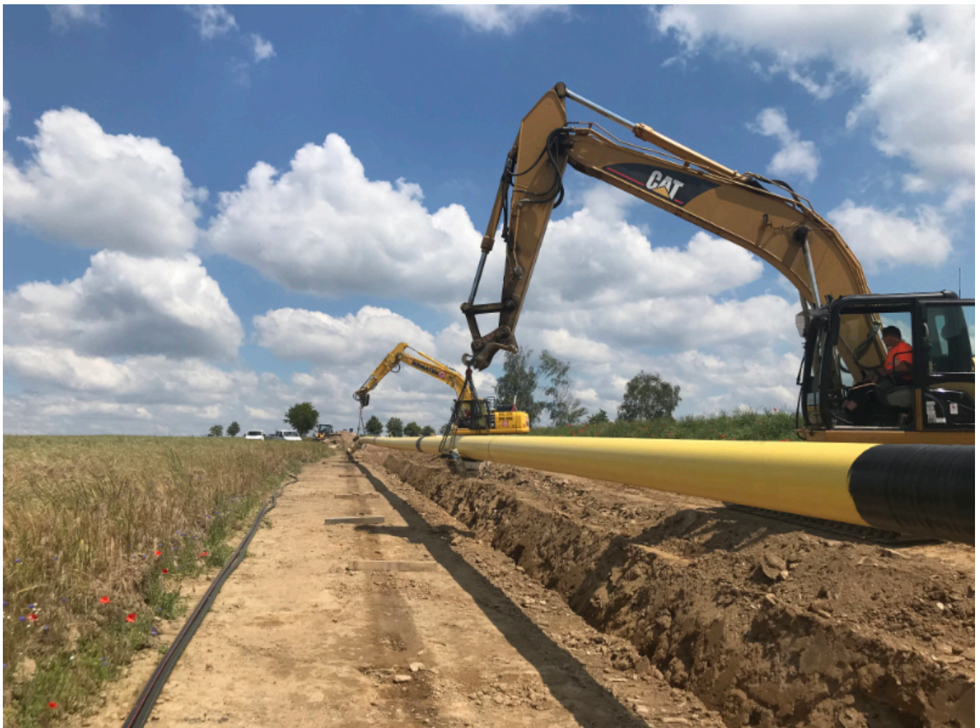
Leitungsbau bei der ONTRAS Gastransport GmbH. Quelle ONTRAS Gastransport GmbH
