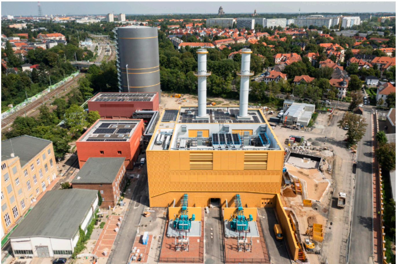
Das wasserstofffähige Heizkraftwerk Leipzig-Süd, Quelle Leipziger Gruppe
