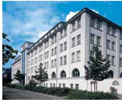
Neue Kauffahrtel Chemnitz.
