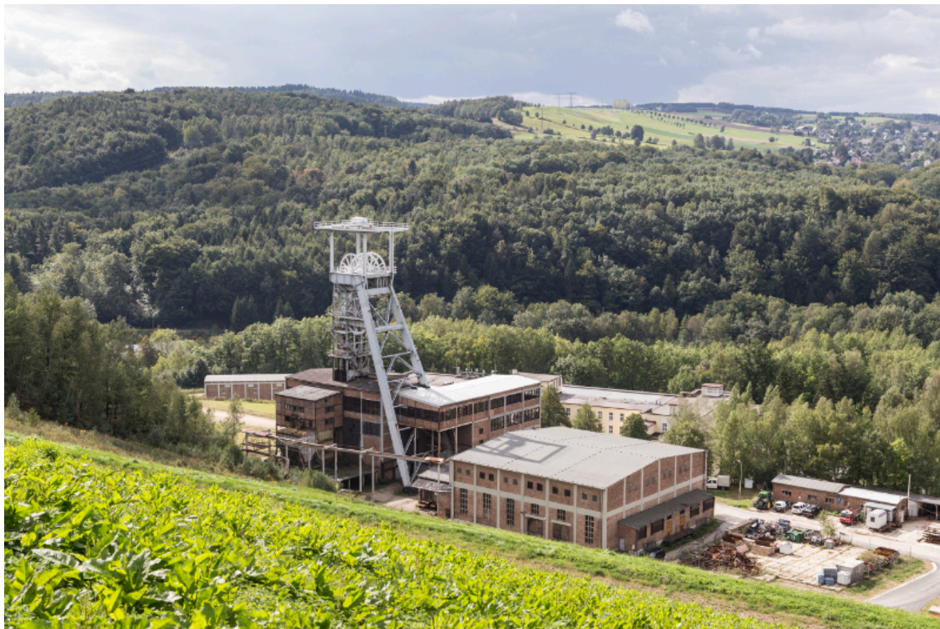
Der stillgelegte Schacht 371 des Uranbergwerks der SDAG Wismut bei Hartenstein. Quelle Marko Borrmann/Welterbe Montanregion Erzgebirge e. V.
