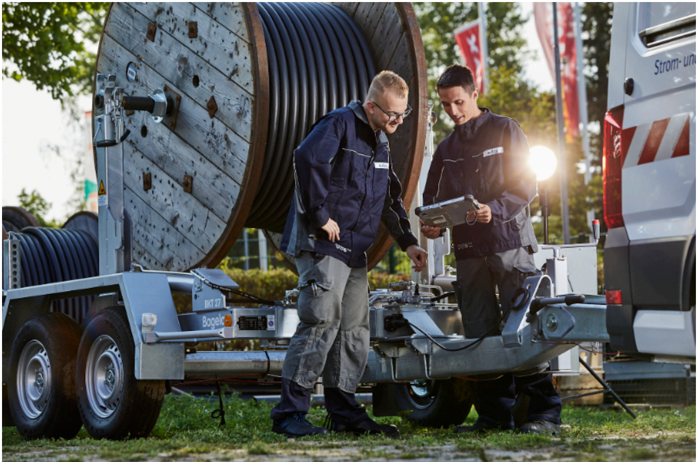
E.DIS Kabelverlegung. Foto: E.DIS
