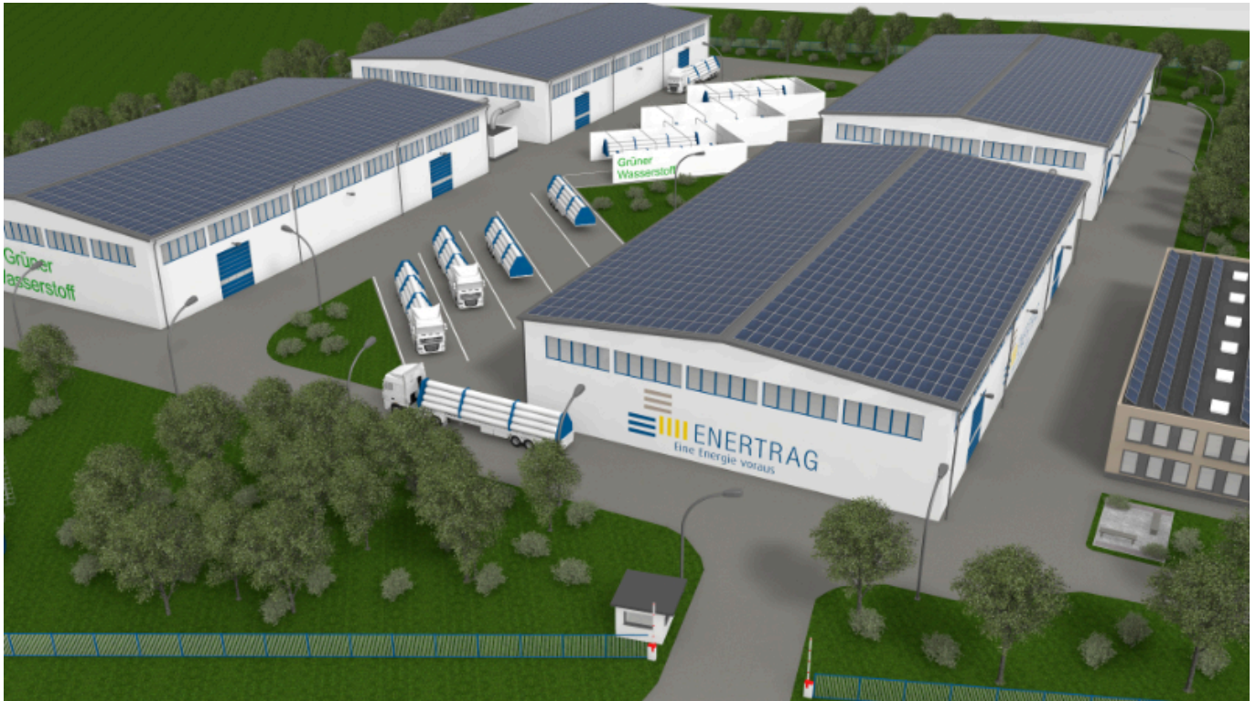
Modell der künftigen Wasserstoff-Fabrik der Firma ENERTRAG in Falkenhagen. Quelle: ENERTRAG
