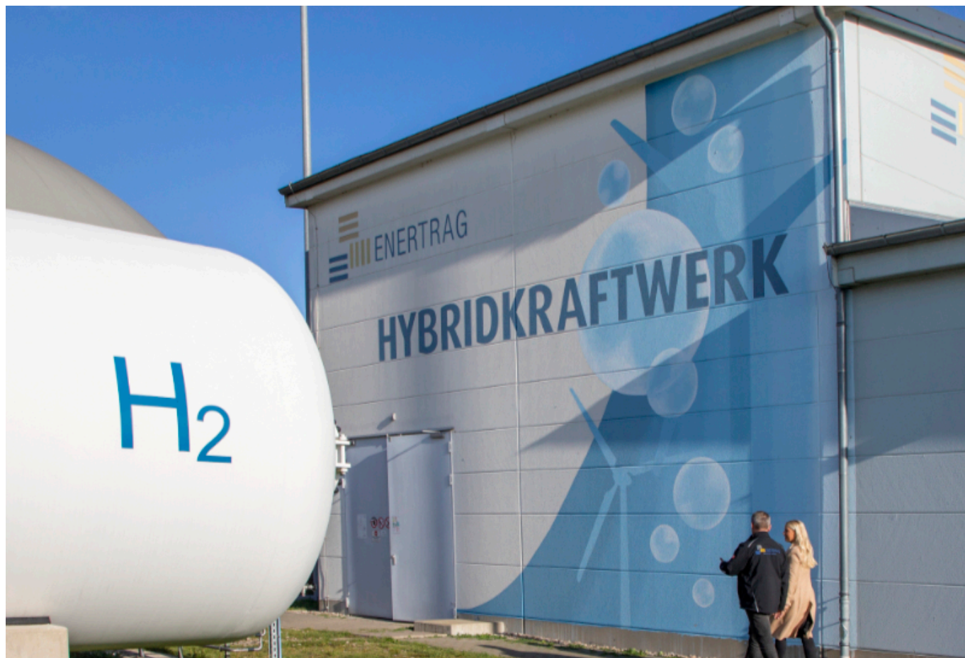
Enertrag Anlagen Hybridkraftwerk Prenzlau. Foto: ENERTRAG
