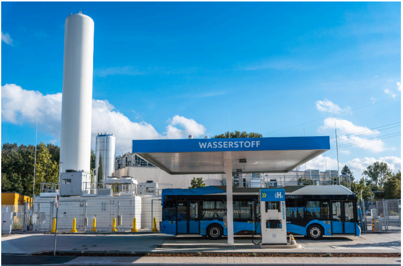
Wasserstofftankstelle der H2 MOBILITY Deutschland. Foto: H2 MOBILITY Deutschland GmbH & Co. KG
