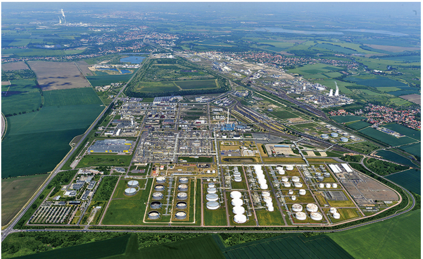
Der Chemiepark Leuna aus der Luft betrachtet. Copy: Ralf Lehmann
