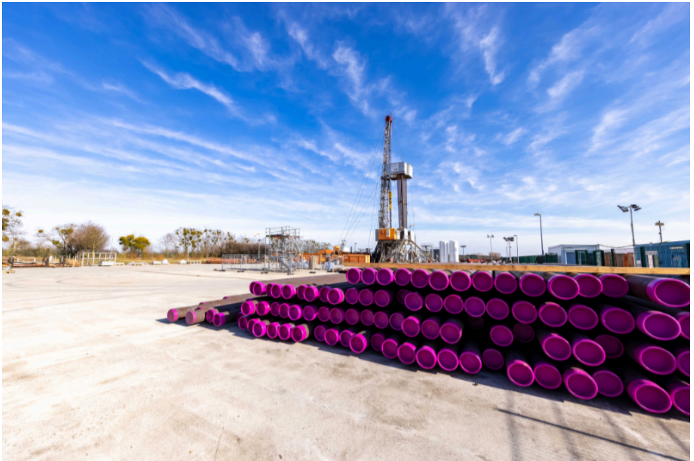
Rüdersdorf, EWE Gasspeicher.
