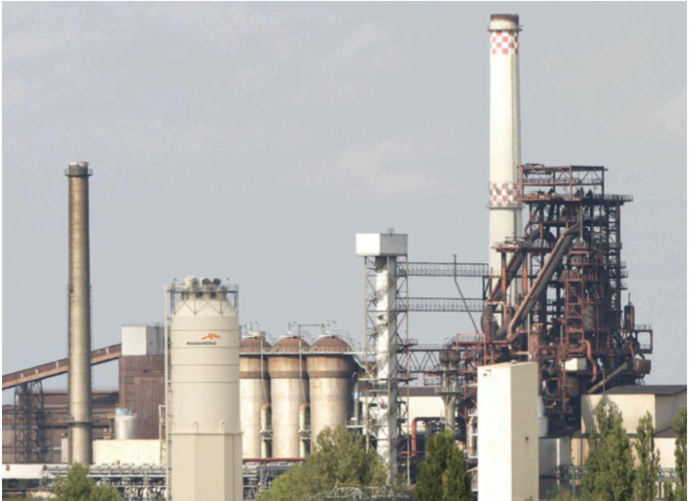
Das ArcelorMittal-Stahlwerk in Eisenhüttenstadt Copyright: ArcelorMittal
