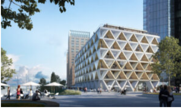
The Cradle Düsseldorf_Quelle_HPP Architekten_Copyright_INTERBODEN_bloomimages
