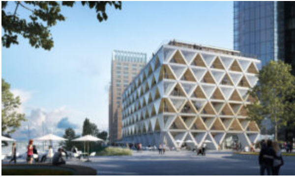
The Cradle Düsseldorf_Quelle_HPP Architekten_Copyright_INTERBODEN_bloomimages
