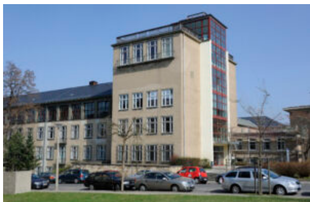
Der Barkhausenbau an der TU Dresden.
