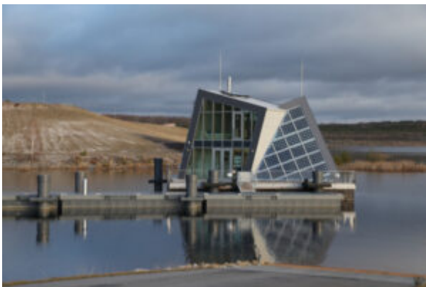
Das autartec®-Haus des Fraunhofer IVI am Bergheider See. Copyright: Fraunhofer IVI
