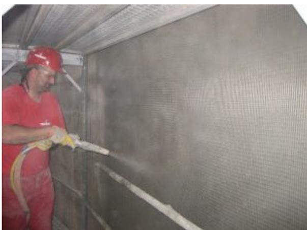
Foto: Mit hauchdünnem Auftrag von 14.000 Quadratmeter Textilbeton
